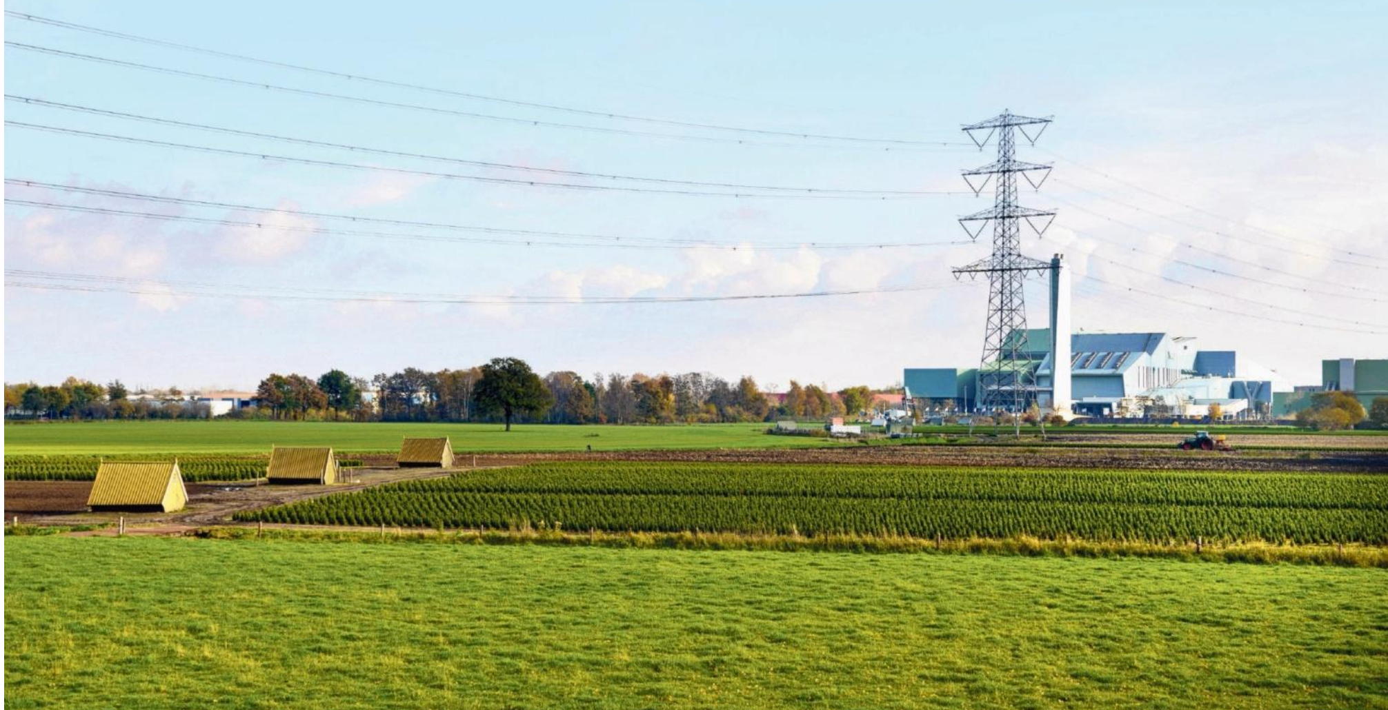
Zouthuisjes bij de cavernes (ondergrondse holtes) nabij Hengelo, waar ondergrondse pijpen pekkelwater richting de fabriek brengen. Als het zout eruit is, stroomt het overgebleven water in de cavernes.
